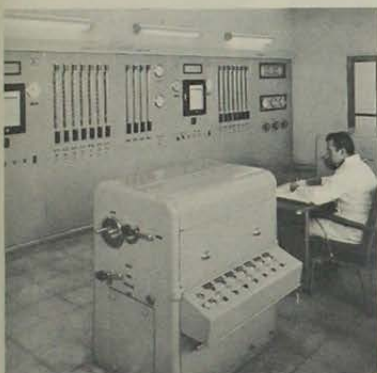
Sala de control de producción de gas de la planta de cracking catalítico instalada en la Fábrica San Borja.
