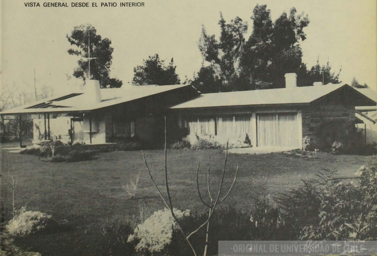
VISTA GENERAL DESDE EL PATIO INTERIOR
