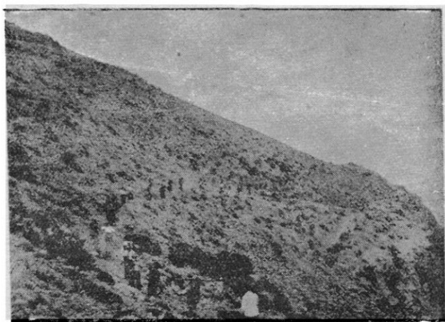
Fig. 3—Obreros transportando los cables
